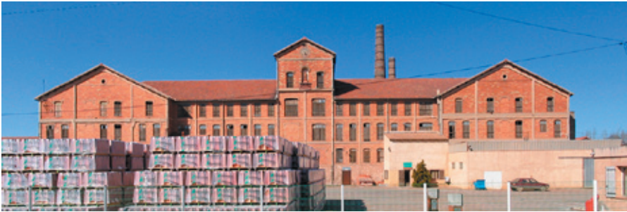
Façade Sud dans l'état actuel. Structure en béton et murs en pierre pour le Rez-de-chaussé puis en brique pour les autres étages.
