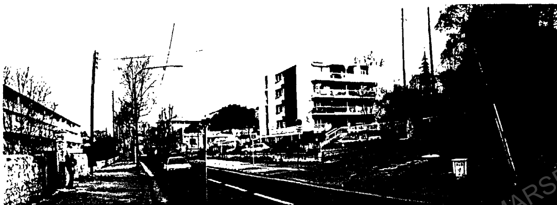
LE SITE : VUE VERS L'EST DEPUIS LE BOULEVARD DE SAINT LOUP
