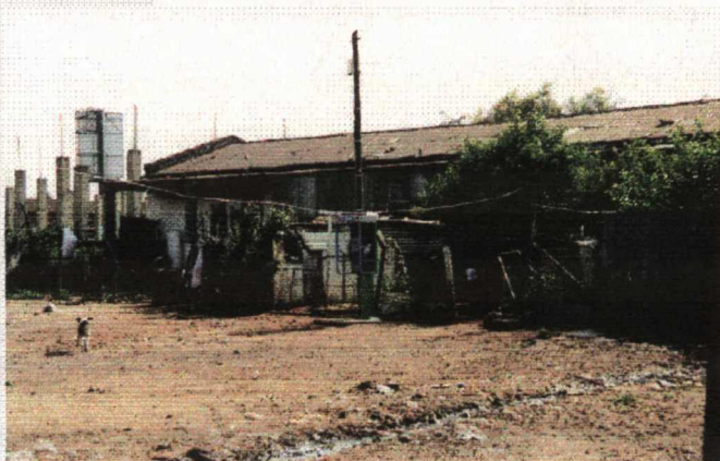
Une des rares cabines téléphoniques de Kliptown. L'absence de réseau d'évacuation des eaux oblige les habitants à creuser eux-mêmes des rigoles à travers les rues
