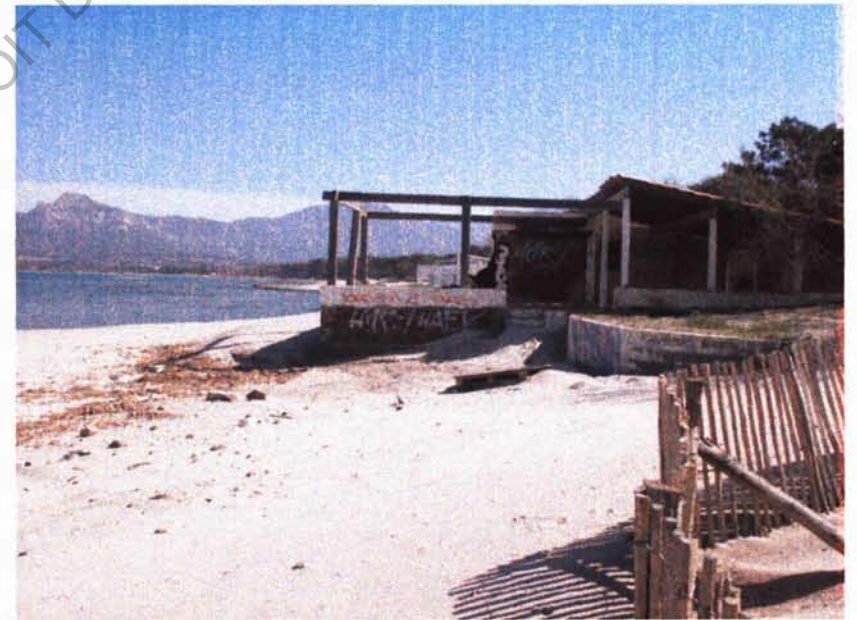
L'ancien Corsica Beach, toujours en place
