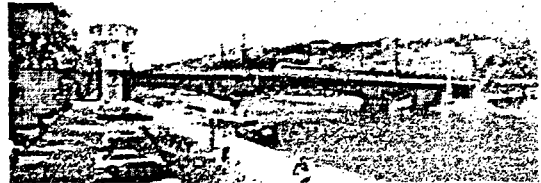
1) Pont ferroviaire de Perrache
