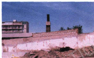
Mur fermant la place du côté boulevard Saint-Jean
