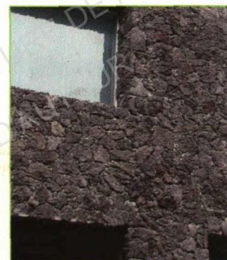
Détail du Tezontle utilisé en parement à partir de modules ou de manière brute
