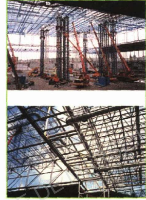
Photos de nappe tridimensionnelle apparente utilisée comme couverture sur plusieurs hectares de site industriel (structure légère, minimum de matière et d'appuis, faible coût au m 2 , rapidité de mise en œuvre, ...)
