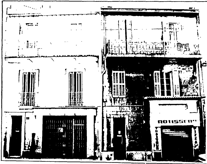
Les façades sur rue du boulevard Fenouil
